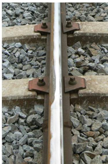
Foto 9. Soldadura Pk 6,515 vía 1
