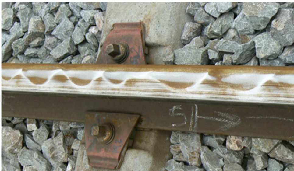
Foto 4. Rastros de movimiento transversal de la rueda por deslizamiento en vía 2 en Pk 12,520
