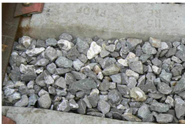
Foto 27. Balasto de tipo diferente en Pk 9,030
