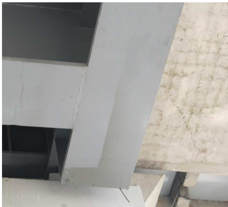
Foto 54. Patín inferior con acero quebrantado
