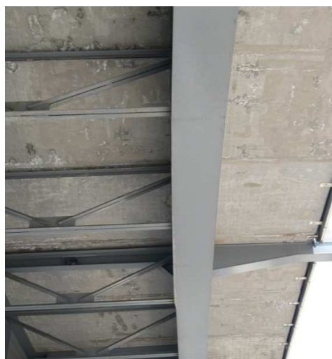
Foto 49. Variación de color del concreto no uniforme sobre vigas y tabletas
