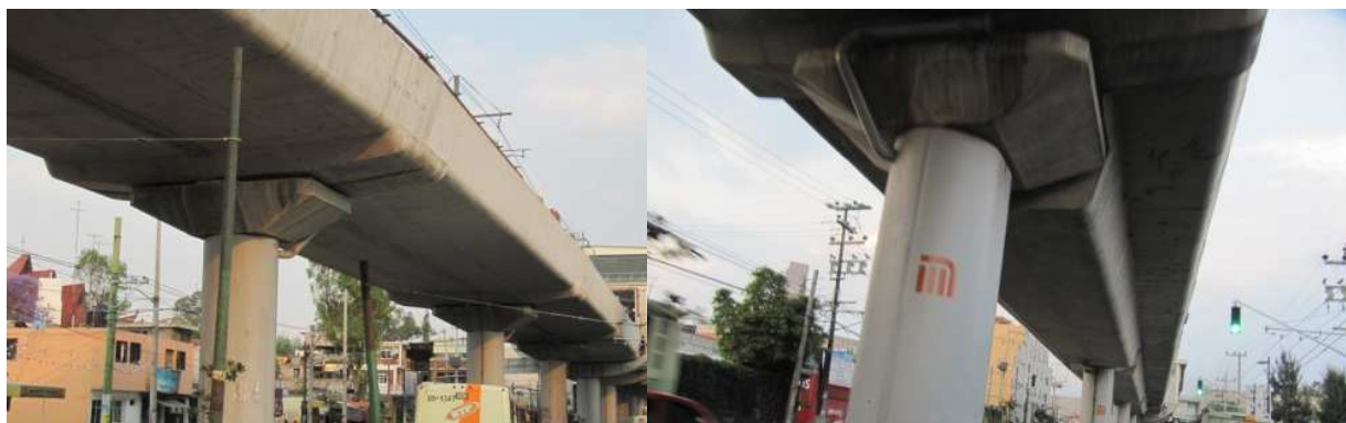
Foto 44. Traveses de hormigón en doble U con columna en hormigón
