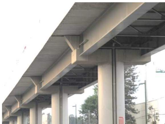
Foto 42. Trabe compuesta con columna en hormigón
