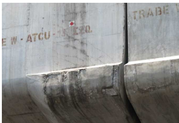
Foto 51. Calidad de los sellados de mortero en la extremidad de los capiteles
