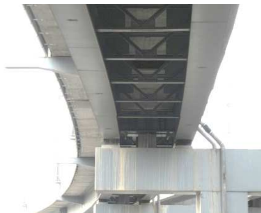
Foto 43. Traveses compuestas paralelas con columna en acero
