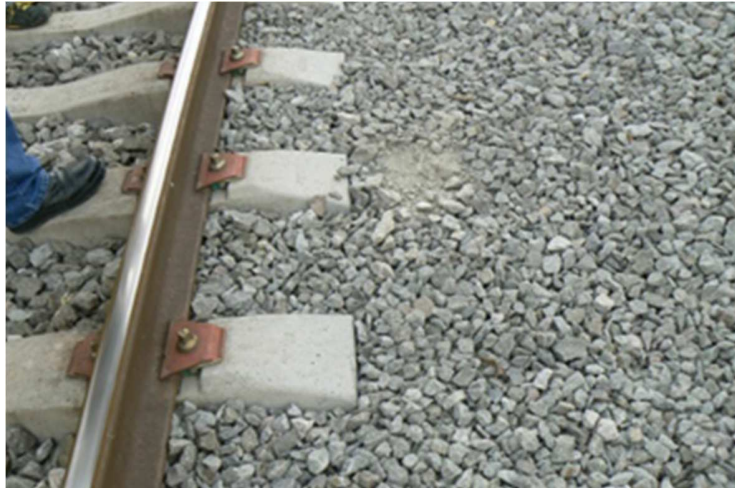
Foto 32. Elementos finos en el balasto Pk 6,015 vía 2
