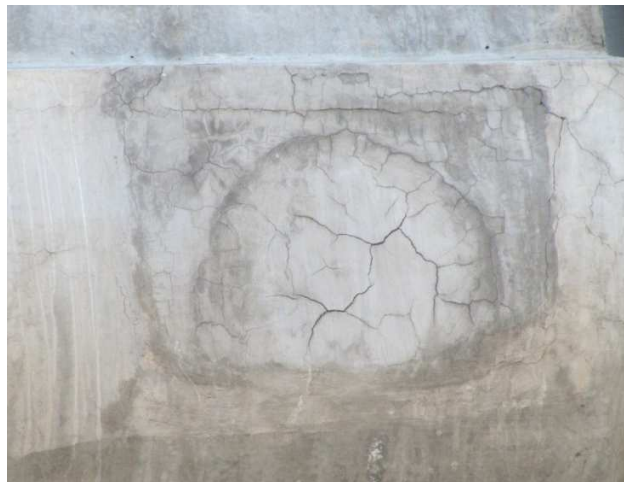
Foto 50. Fisuras del concreto y del mortero de sellado
