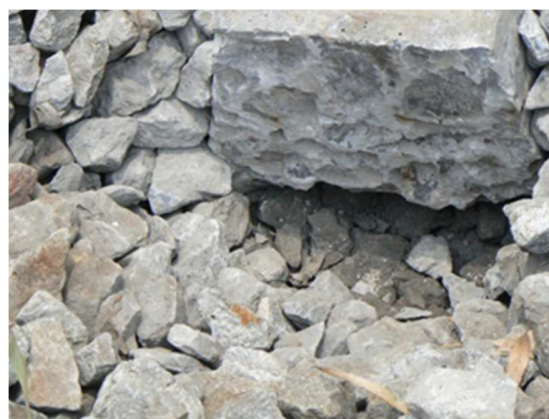
Foto 22. Cabeza del durmiente en Pk 4,765 vía 1 (Después de desguarnecido)
