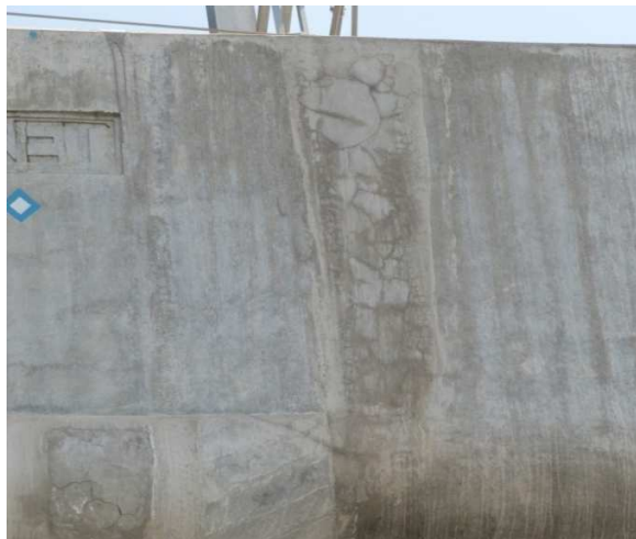
Foto 50. Fisuras del concreto y del mortero de sellado
