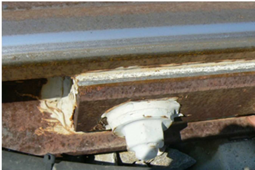
Foto 35. Junta aislante con rastro sobre la brida en la estación de Tlahuac
