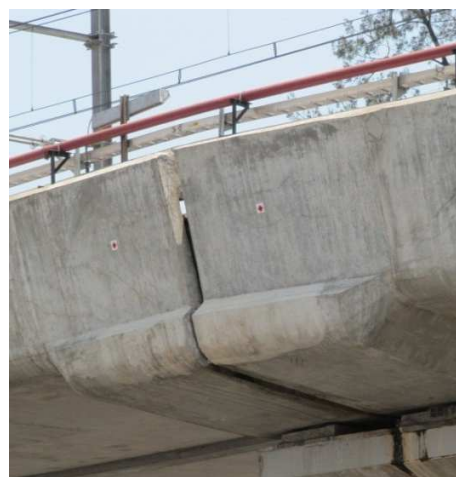
Foto 53. Flecha excesiva de un tramo y una rotación de la extremidad
