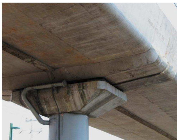
Foto 49. Variación de color del concreto no uniforme sobre vigas y tabletas
