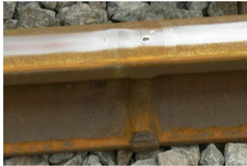
Foto 10. Soldadura Pk 16,820 vía 2
