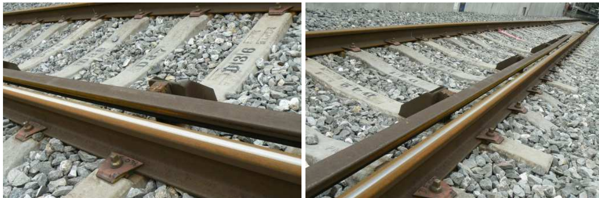
Foto 13. Trazas de fricción (zona activa del contrarriel) comprendido entre el 3° y el 6° soporte (curva 27)
